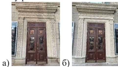
Рис. 3. Портки вхідних дверей центрального фасаду: а) Нереставрований; б) Реставрований студентами
